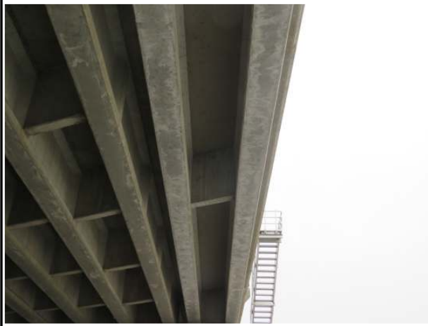
바닥판 및 거더(S1) 전경
