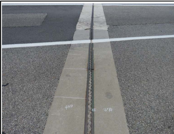
A2 신축이음장치 전경
